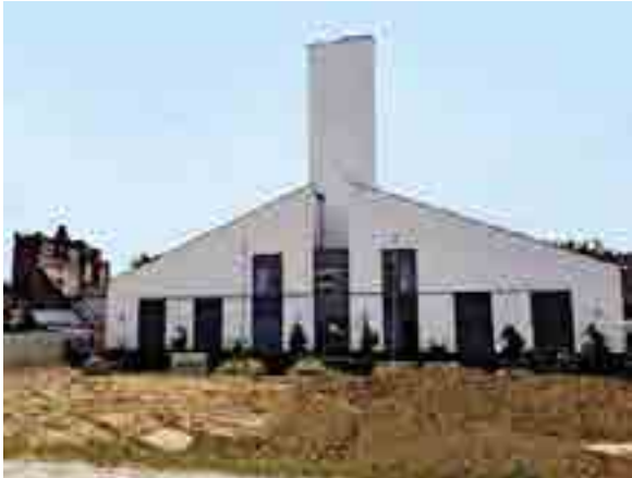
Blockheizkraftwerk im Projekt „52 Grad Nord“, Berlin
