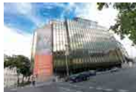
Beim Rückbau des Objekts Rathausstraße 1 arbeitet die BUWOG Group mit dem Kooperationsnetzwerk „BauKarussell“ und der ReUse-Plattform „Harvest Map“ zusammen.
